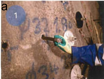
1 Установка первого картриджа и гайки
