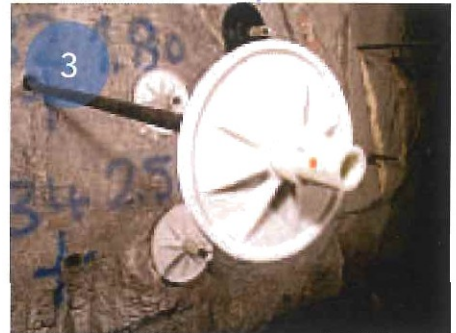
3 Установка второго картриджа Установка диска и гайки
