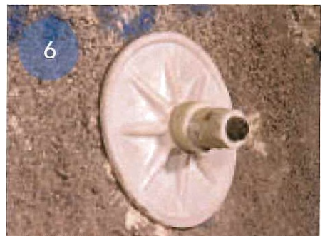
6 Окончательное натяжение анкера KGC KW
