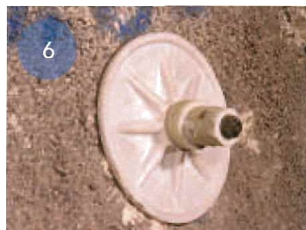
6 Endverspannung des KGC KW-Ankers
