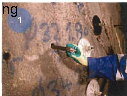
1 Positionierung der ersten Patrone und der Mutter
