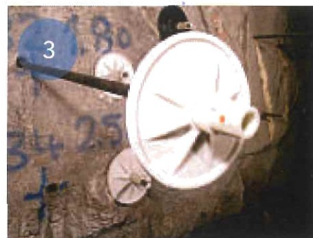
3 Einsetzen der zweiten Patrone Einbau der Scheibe
